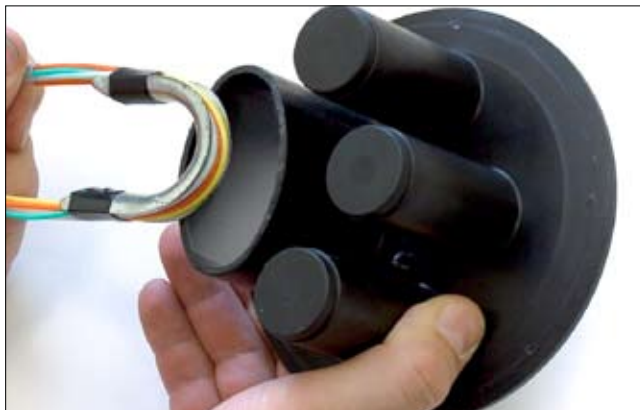
Рис. 3.7. Ввод транзитной петли в овальный патрубок с помощью специального приспособления представляющего собой оправку с плавным изгибом. Пучок модулей закреплён на приспособлении бандажами из липкой ПВХ ленты.
