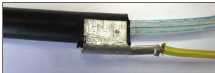
Рисунок 4.10 – Установка зажима перемычки на отогнутый участок оболочки ОК
