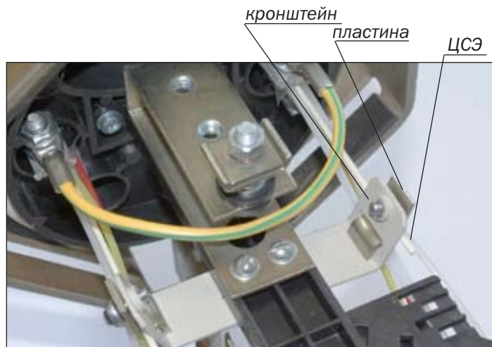
Рисунок 5.2 – Крепление ЦСЭ ОК, вводимых в цилиндрические патрубки
