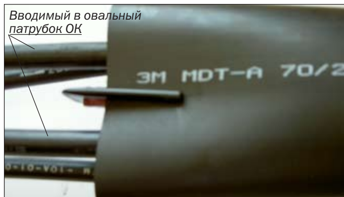
Рисунок 4.13 – Установка разветвительного зажима
